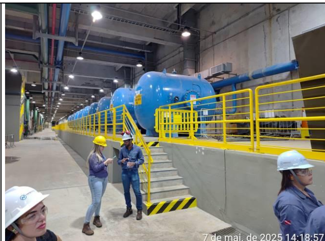
Foto 14: UHE Belo Monte – Galeria Mecânica Inferior. Sistema de ar comprimido.
