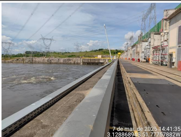
Foto 17: UHE Belo Monte – Pátio dos transformadores. Notar no centro da foto o local das caixas separadoras de água e óleo do septo central.
