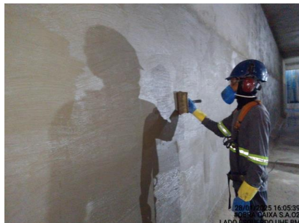
Foto 20: UHE Belo Monte – Pátio dos transformadores. Vista interna da caixa separadora de água e óleo do septo central (lado esquerdo) durante a manutenção. Notar que todo o sistema foi limpo, recuperado e impermeabilizado novamente. Foto: Norte Energia.
