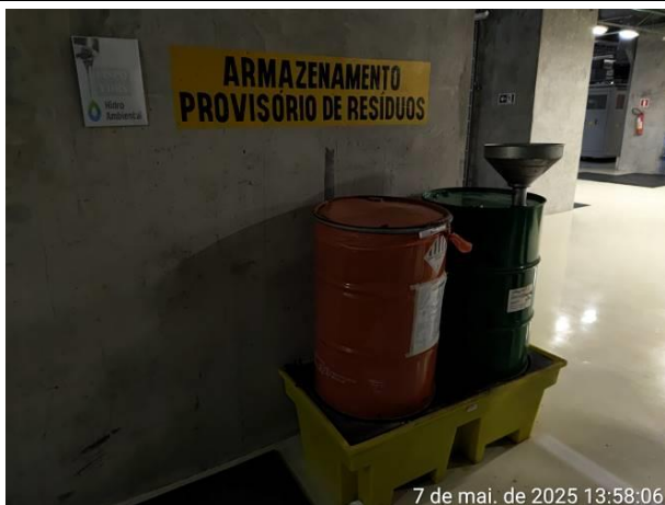
Foto 03: UHE Belo Monte – Galeria Mecânica Superior. Tambores para armazenamento de materiais contaminados e de óleos usados/ notar o pallet com caixa para contenção de vazamentos.
