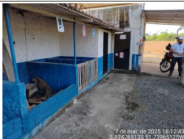
Foto 30: UHE Belo Monte – Canteiro da empresa Rocha Engenharia. Baias para armazenamento de resíduos recicláveis e armário trancado de resíduos perigosos.
