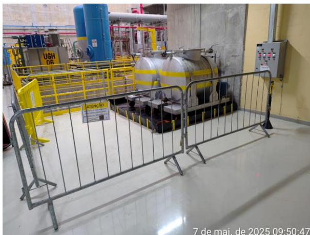
Foto 13: UHE Pimental. Galeria Mecânica – Tanques móveis para armazenamento de óleo lubrificante dos equipamentos de geração.
