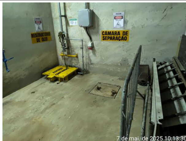
Foto 16: UHE Pimental. Galeria 64,00 (piso inferior à Galeria Mecânica). Escotilha para o sistema de separação de água e óleo da casa de força.
