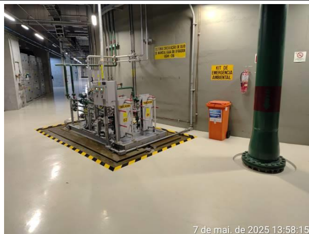
Foto 04: UHE Belo Monte – Galeria Mecânica Superior. Kit de mitigação de emergência ambiental; os kits possuem sacos plásticos, serragem, tolas e matas absorventes, máscara, luvas e ferramentas manuais de borracha ou plástico.
