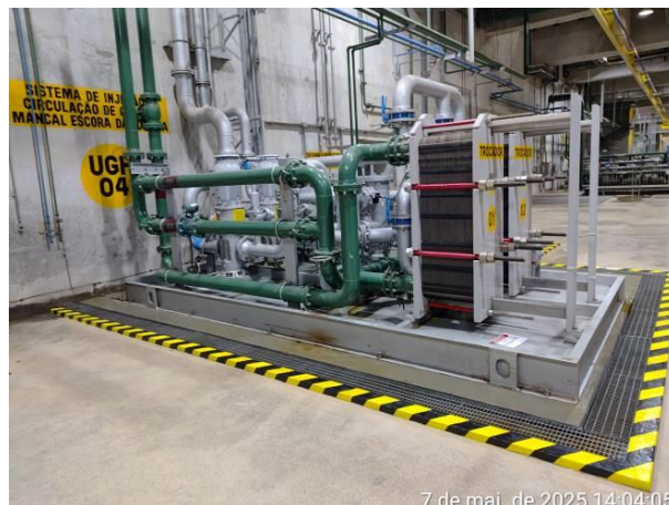
Foto 08: UHE Belo Monte – Galeria Mecânica Superior – Detalhe de equipamento montado em skid industrial com contenção de vazamento e instalado dentro do perímetro da canaleta de drenagem.
