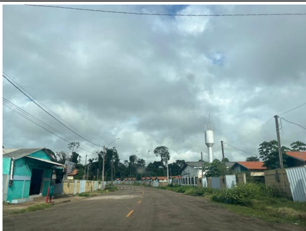
Foto 09: RUC Tavaquara – residências habitadas e comércio local em funcionamento (a esquerda).
