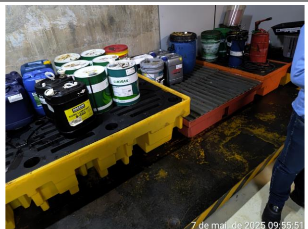
Foto 06: UHE Pimental. Galeria Mecânica – Sala de Produtos Químicos. Embalagens e tambores com produtos novos ou em uso armazenados em paletes com contenção de vazamentos e dentro de bacias de grande volume.
