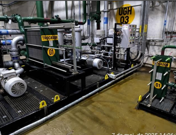
Foto 12: UHE Belo Monte – Galeria Mecânica Superior – Idem.
