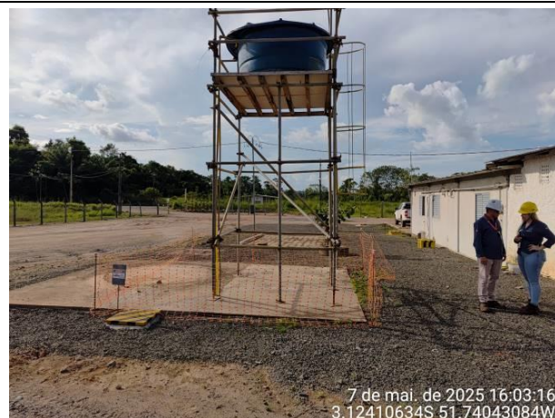
Foto 24: UHE Belo Monte – Canteiro da empresa Rocha Engenharia. Saneamento – caixa de armazenamento de água tratada e potável.
