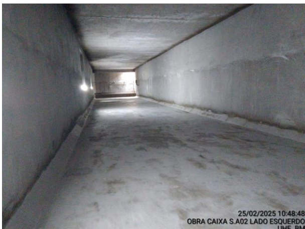
Foto 19: UHE Belo Monte – Pátio dos transformadores. Vista interna da caixa separadora de água e óleo do septo central (lado esquerdo) durante a manutenção. Notar que todo o sistema foi limpo, recuperado e impermeabilizado novamente. Foto: Norte Energia.
