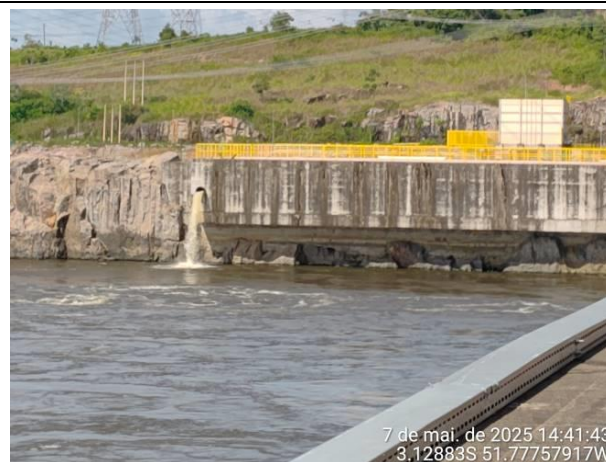
Foto 18: UHE Belo Monte – Pátio dos transformadores. Detalhe do lançamento de efluente industrial tratado na caixa separadora de água e óleo do septo central (lado esquerdo). A manutenção foi concluída e o sistema voltou a operar no primeiro trimestre de 2025.
