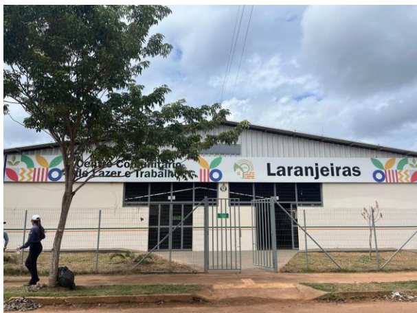
Foto 13: RUC Laranjeiras – Barracão do Centro Comunitário de Lazer do Trabalhador - CCLT.
