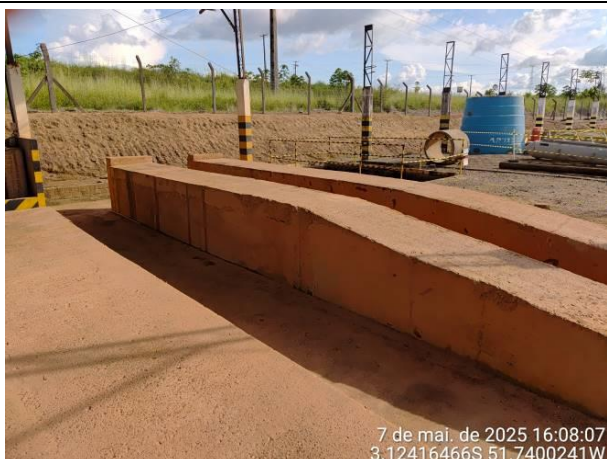
Foto 27: UHE Belo Monte – Canteiro da empresa Rocha Engenharia. Rampa de lavagem e lubrificação de veículos desativada.
