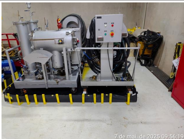
Foto 09: UHE Pimental. Galeria Mecânica – Sala de Produtos Químicos. Equipamentos para regeneração de óleo na manutenção das máquinas de geração de energia elétrica. Notar as bacias de contenção de vazamentos.
