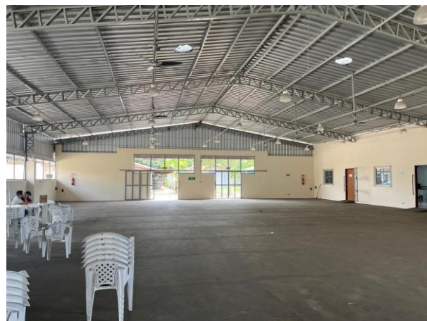
Foto 14: RUC Laranjeiras – Instalações internas do Centro Comunitário de Lazer do Trabalhador - CCLT.
