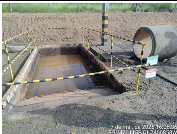
Foto 28: UHE Belo Monte – Canteiro da empresa Rocha Engenharia. Caixa de separação de água e óleo da rampa de lavagem e lubrificação de veículos desativada. Notar o acúmulo de água no sistema e o risco de propagação de vetores.
